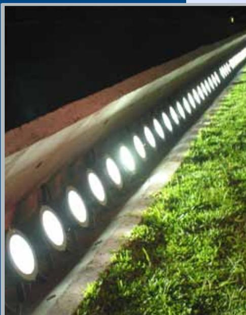
Bateria de projetores Focal para iluminação da fachada com foco ultra-fechado.
